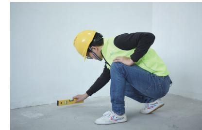
确认地面平整度，2米内高低差不大于5毫米。
