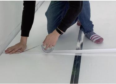
白晶板拼缝处使用铝箔胶带做密封处理。
