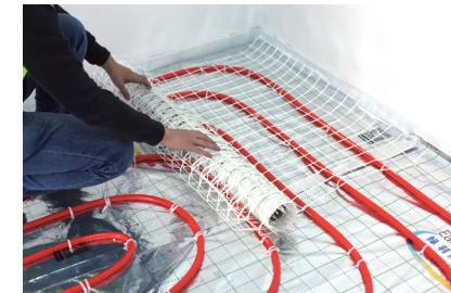
在管道上方铺设硅晶网，降低回填层开裂的可能性。
