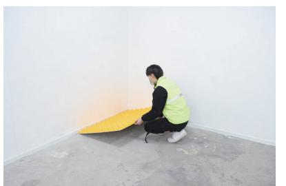
铺设围棋板，由外墙向内墙铺设，贴合墙面。
