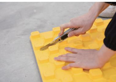
切割模块，使用工具刀时尽量保持笔直切割模块。
